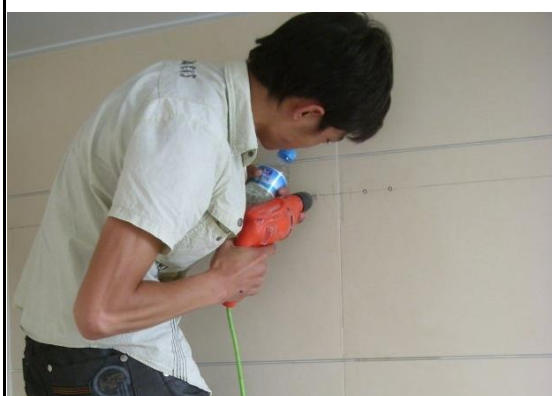
图 6-6 吊柜安装前用玻璃钻在瓷砖上钻孔，固定膨胀螺栓
