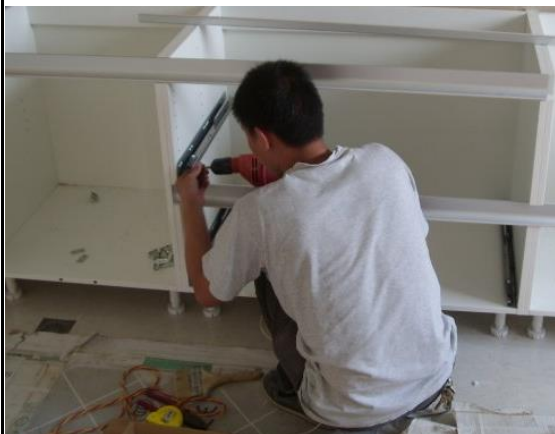
图 6-16 安装推拉门的导轨
