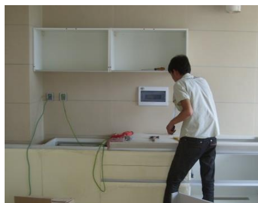
图 6-7 安装好吊柜柜体
