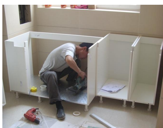
图 6-3 工人在安装地柜脚架
