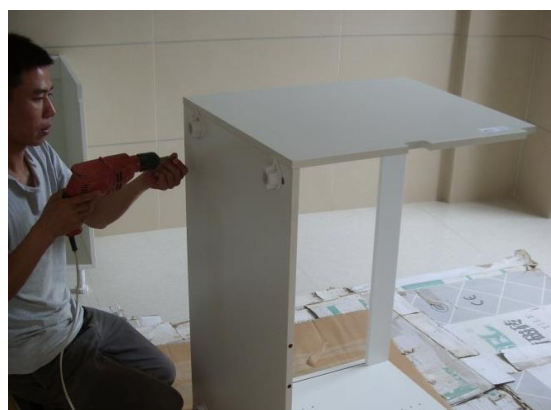
图 6-3 工人在安装地柜脚架
