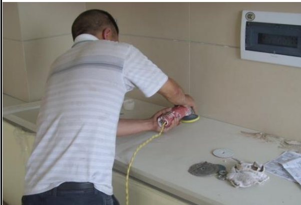
图 6-8 对准备安装的石英石台面进行打磨
