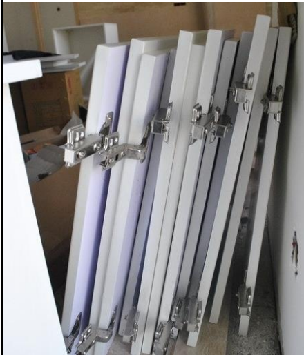
图 6-12 先在门扇上装好铰链
