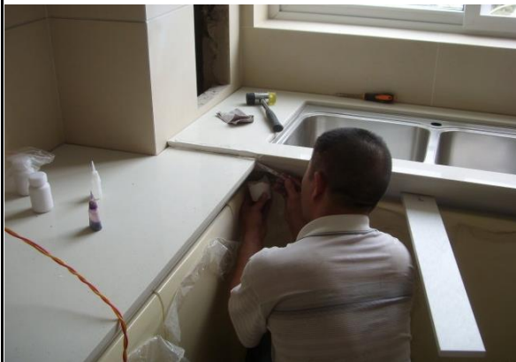
图 6-8 对准备安装的石英石台面进行打磨
