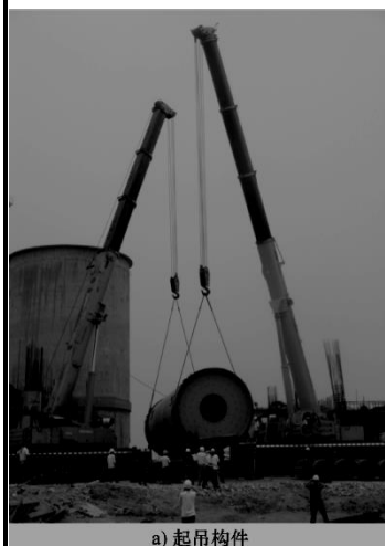
a) 起吊构件
