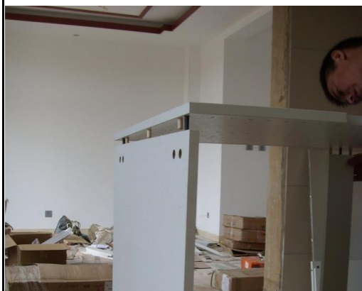
图 6-2 板材之间靠专用连接件或者螺丝固定
