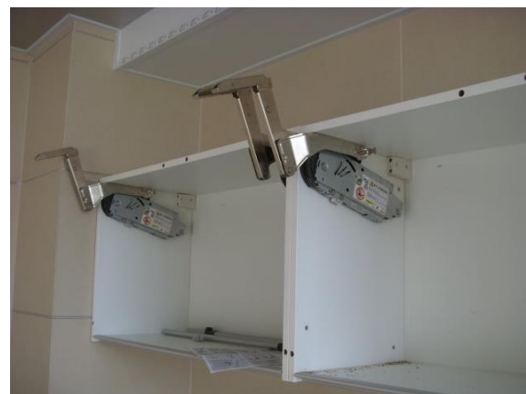
图 6-14 柜门的平移上开装置
