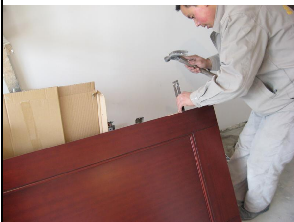
图 6-18 门套的固定
